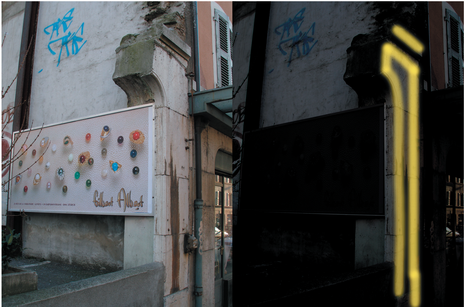
traces sur le mur de l'immeuble numero dix-sept
